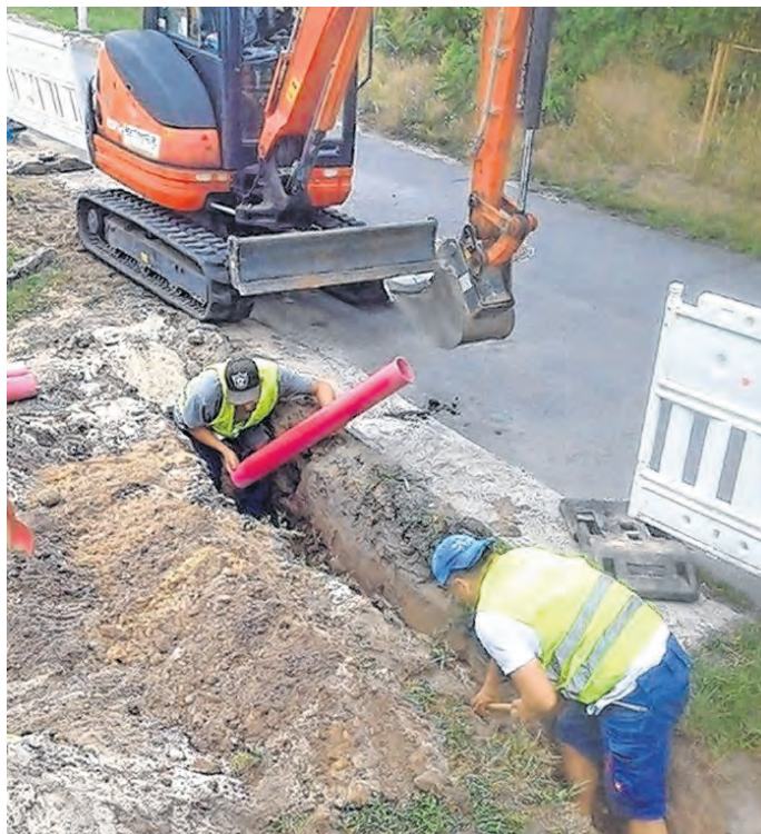
Ab in die Erde: Der Kabel- und Leitungsbau ist eines von mehreren Geschäftsfeldern der EMT Media Electrics.
