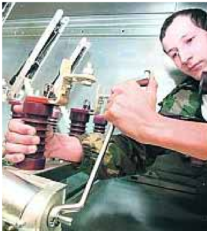
Zusammenbau eines luftisolierten Mittelspannungsfeldes. FOTO: GÜCKEL
