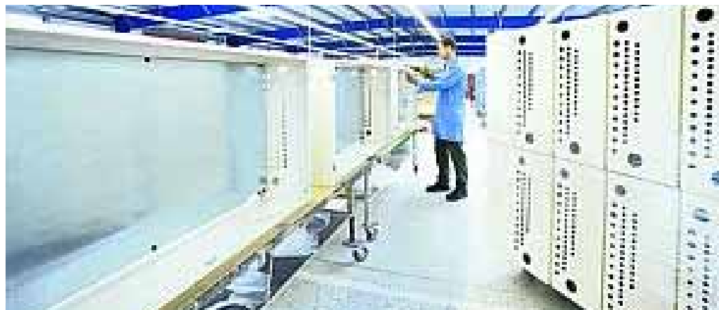
Schaltschrankmontage bei Caleg in Calau.
