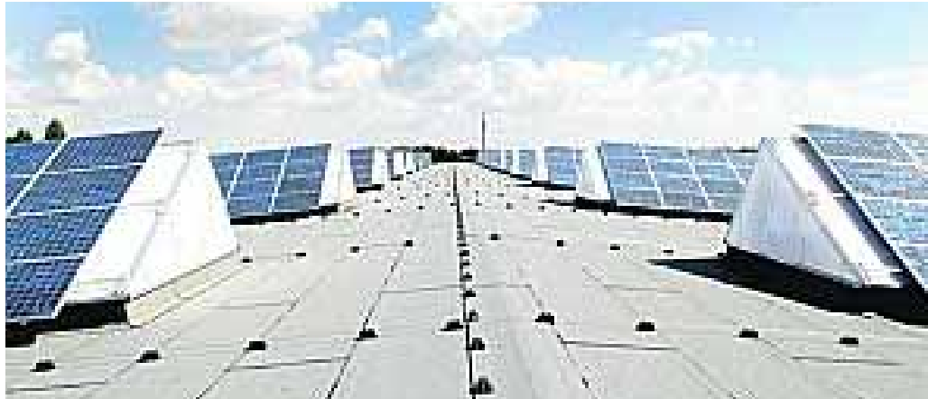
Parken unterm Sonnendeck. Die Firma Opitz bestückt Dächer mit Photovoltaikanlagen.
