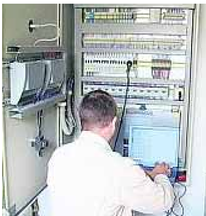
Programmierung einer Low-Oxygen-Anlage.
