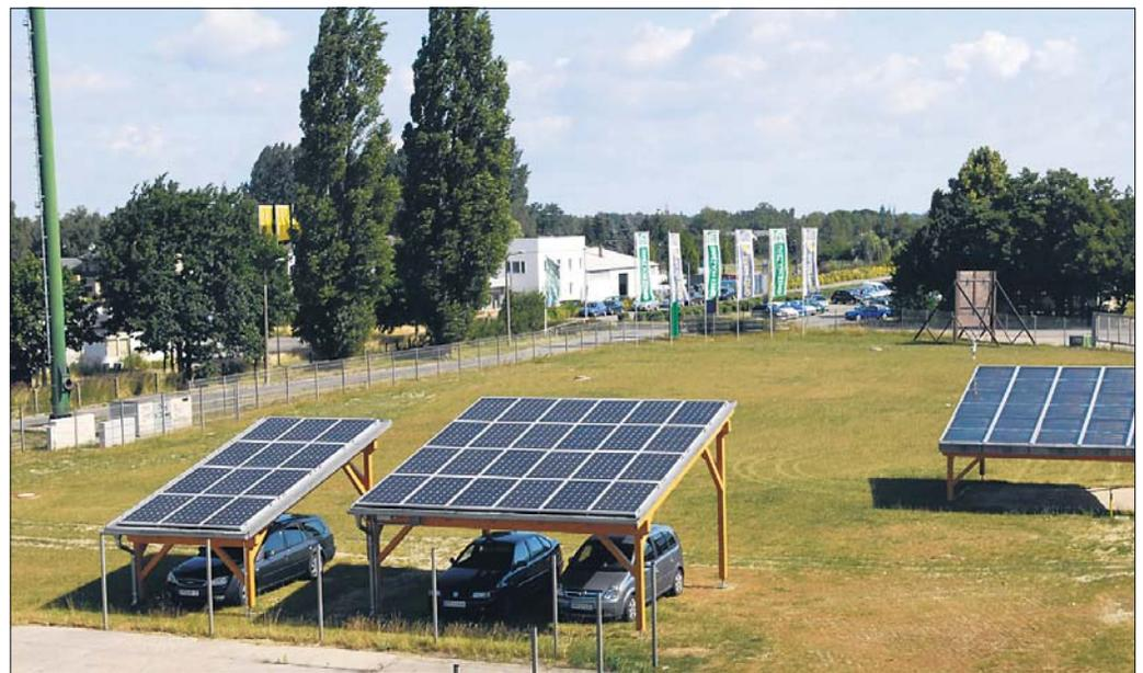
So sehen sie aus, die aus Holz gefertigten Carports mit Solarkollektoren auf dem Dach. Foto: Peter Geisler
