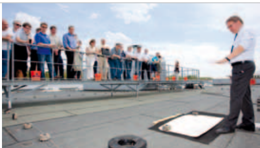
Demonstration der Funktion eines Leckmeldesystems auf zu sanierendem Flachdach.
