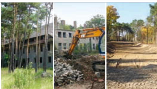
Rückbau eines ehemaligen Stabsgebäudes und Flächenentsiegelung
