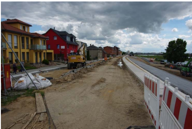
Abbildung 4.4: Baustelle Elbuferpromenade und südliche Elbuferpromenade (September 2020)
