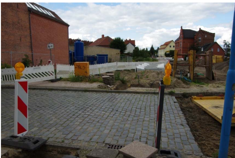
Abbildung 4.6: Altlastensanierung chemische Reinigung
