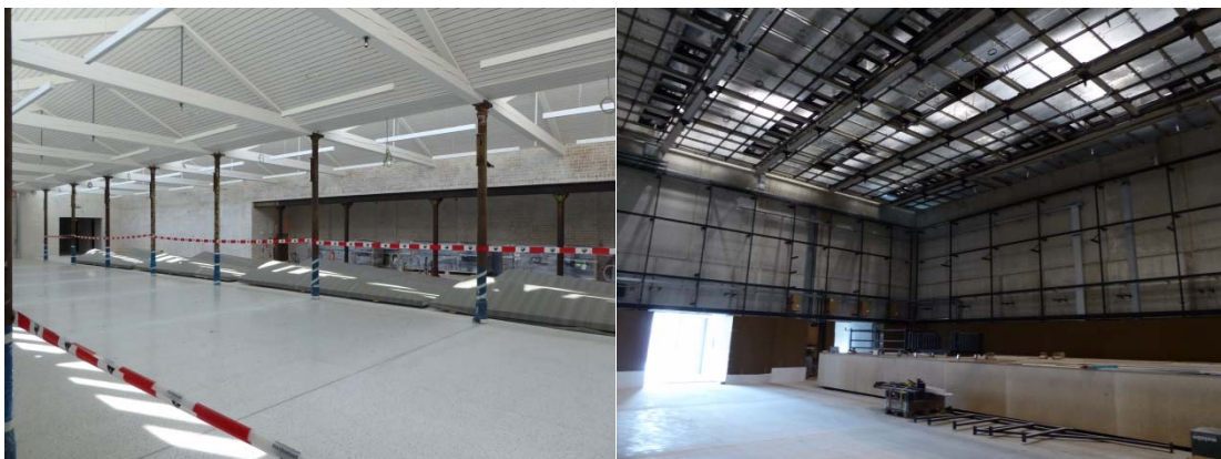
Abbildung 4.25: Blick in die Sheddachhalle mit Akustik- und Brandschutzelementen, Veranstaltungshalle mit Hubbühne
