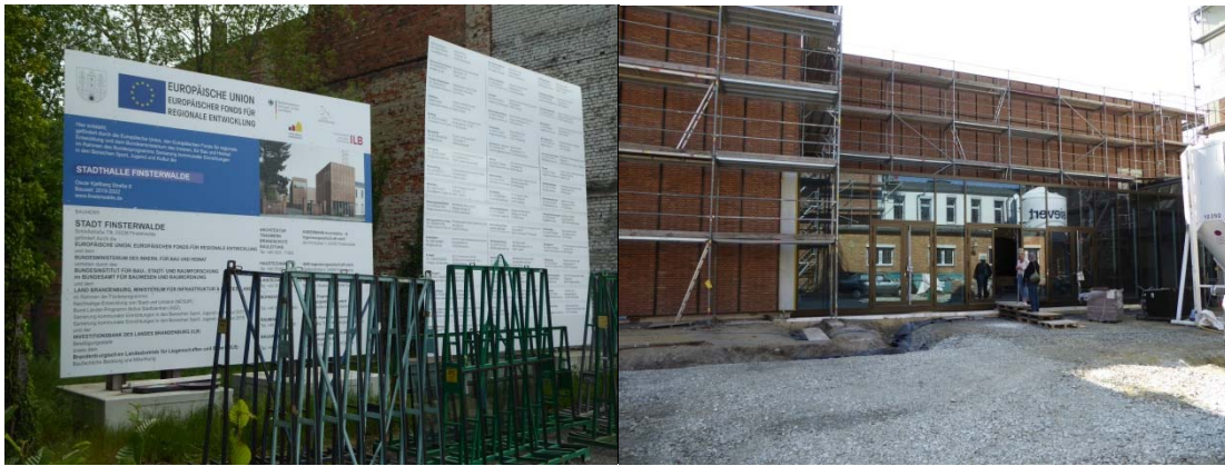
Abbildung 4.23: Eingangsbereich der Kulturweberei
