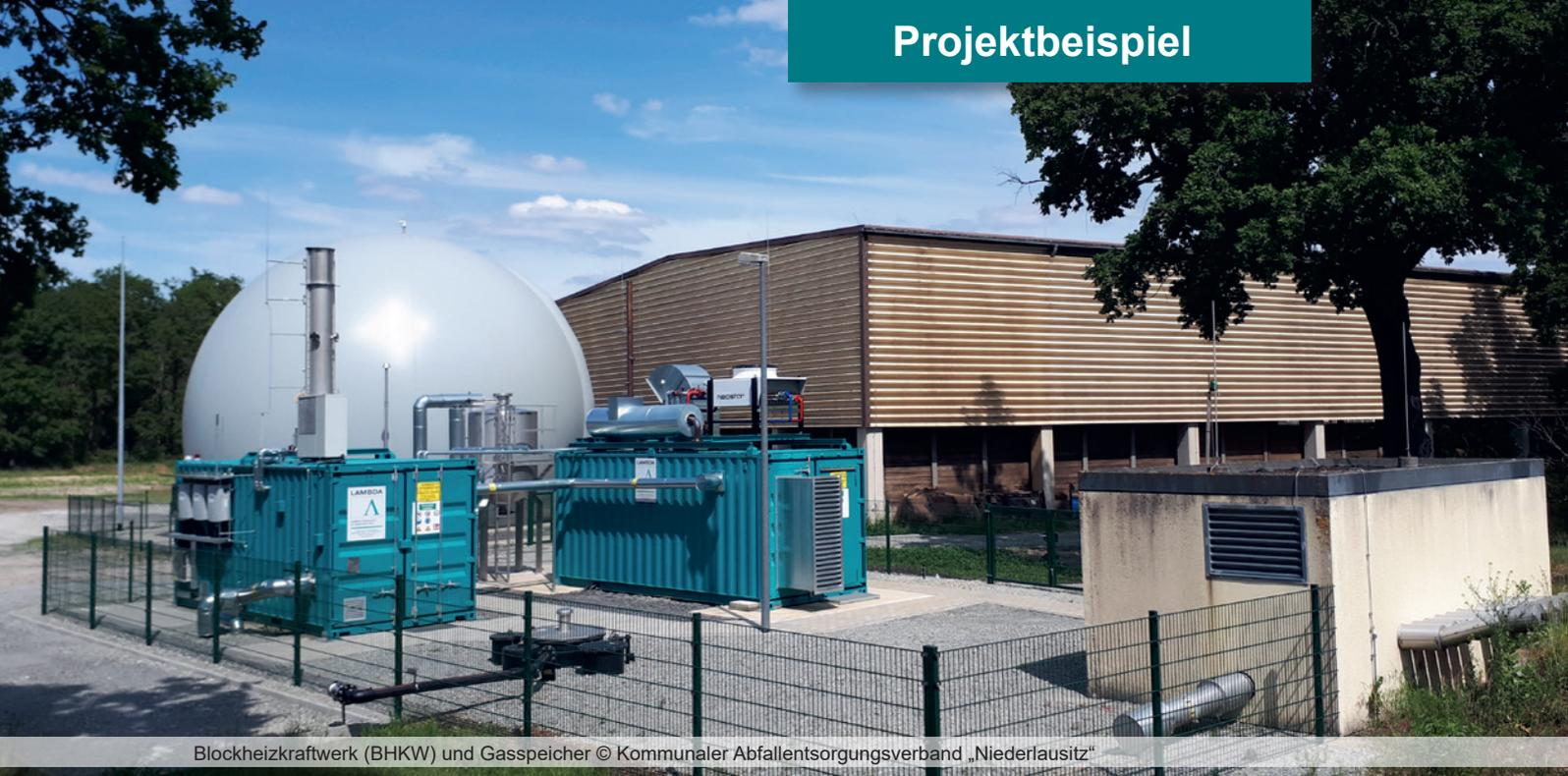
Blockheizkraftwerk (BHKW) und Gasspeicher © Kommunalen Abfallentsorgungsverband „Niederlausitz“
