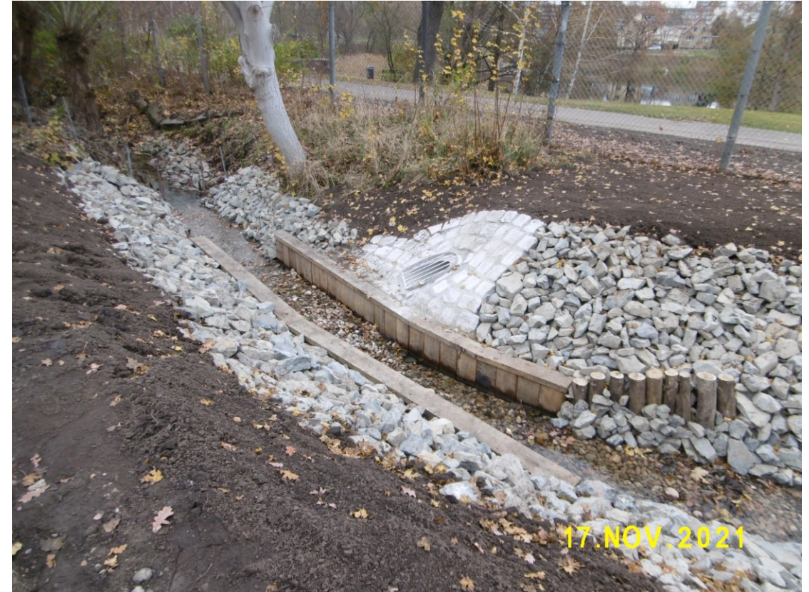
Abschlag von der Nuhne
