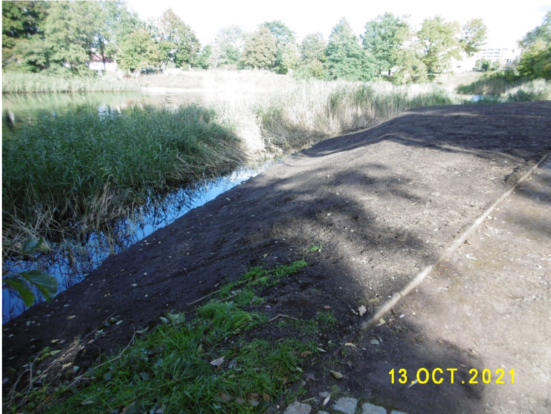
Böschungssicherung mit Oberbodenabdeckung
