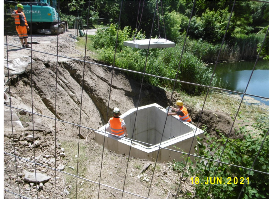
Fertigteil Auslaufbauwerk mit Drossel.
