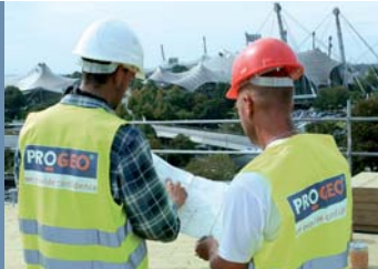
Progeo: Nachhaltigkeit braucht dichte Dächer
