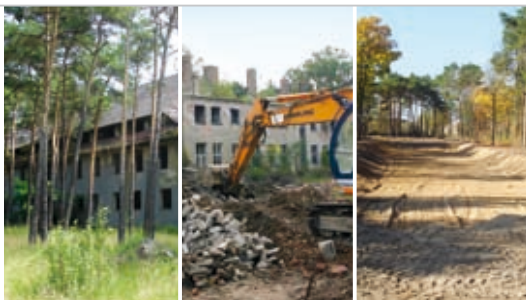
Rückbau eines ehemaligen Stabsgebäudes und Flächenentsiegelung
